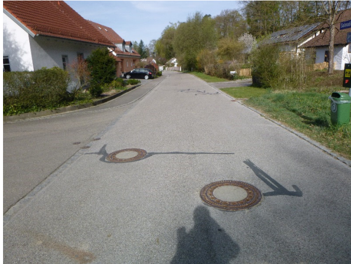
Abbildung 4-3: Salmadinger Straße am Schacht R05403
