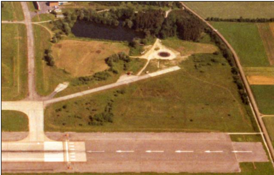
Abbildung 5-6: Luftbildaufnahme ehemaliges Feuerlöschübungsbecken 1988
