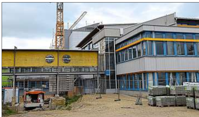
Die halbe Schule eine Baustelle: Die Generalsanierung des Schyren-Gymnasiums kostet wohl 32,75 Millionen Euro. Foto: Ermert
