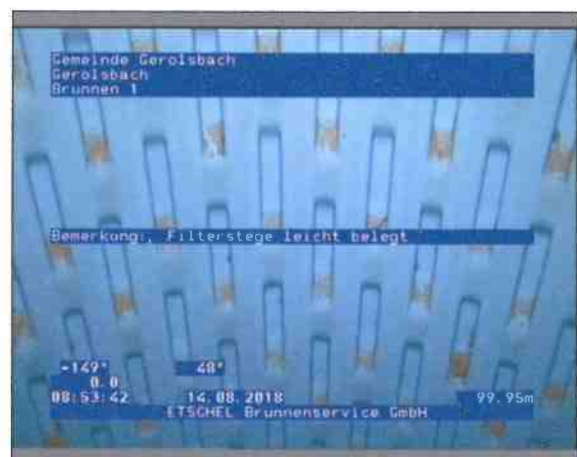
Foto: 1_1_24_14082018_085203_A.JPG 99,95m, Bemerkung: / Filterstege leicht belegt
