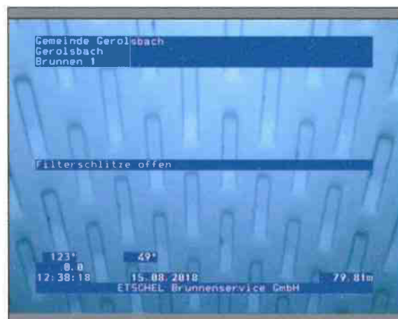
Foto: 1_1_23_15082018_123637_A.JPG 79,81m, Filterschlitze offen
