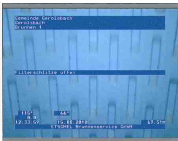
Foto: 1_1_20_15082018_123218_A.JPG 69,51m, Filterschlitzte offen
