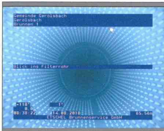
Foto: 1_1_17_14082018_083643_A.JPG 65,56m, Blick ins Filterrohr
