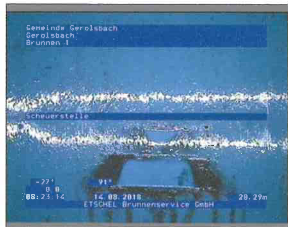
Foto: 1_1_8_14082018_082136_A.JPG 20,29m, Scheuerstelle
