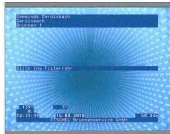
Foto: 1_1_19_15082018_122958_A.JPG 58,24m, Blick ins Filterrohr
