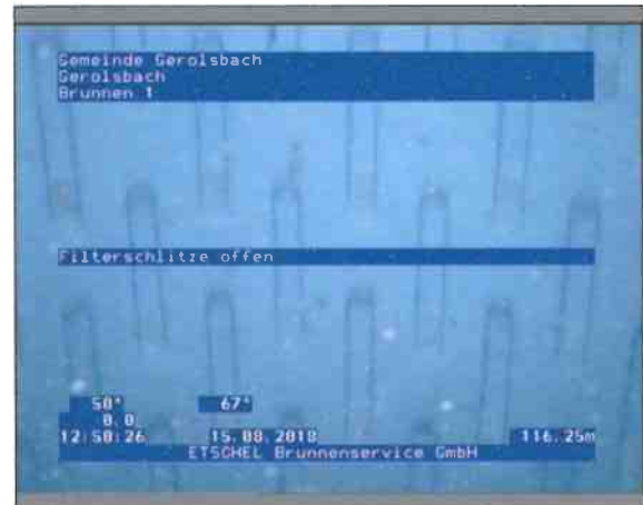
Foto: 1_1_28_15082018_124845_A.JPG 116,25m, Filterschlitze offen
