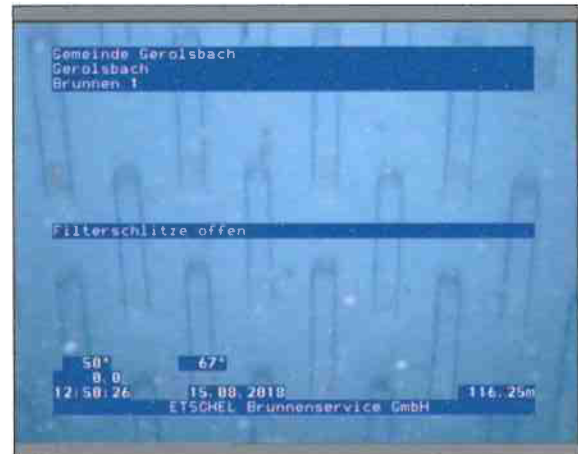
Foto: 1_1_28_15082018_124845_A.JPG 116,25m, Filterschlitz offen
