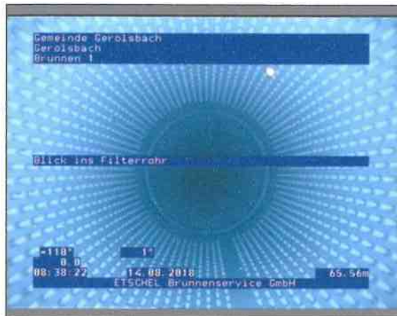
Foto: 1_1_17_14082018_083643_A.JPG 65,56m, Blick ins Filterrohr
