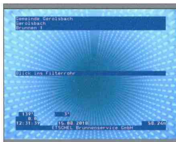
Foto: 1_1_19_15082018_122958_A.JPG 58,24m, Blick ins Filterrohr
