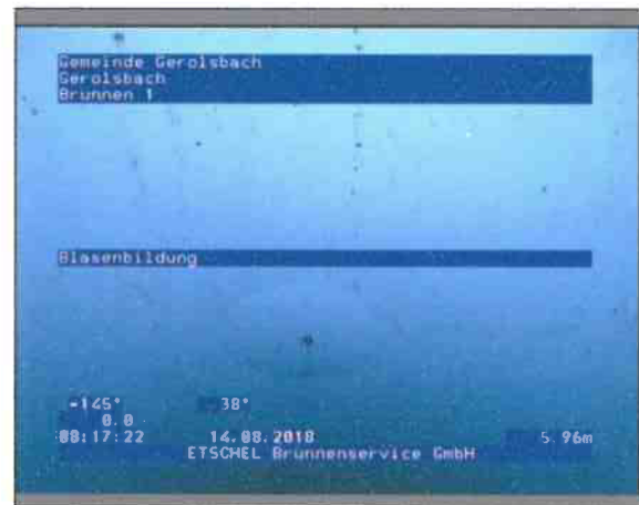
Foto: 1_1_4_14082018_081543_A.JPG 5,96m, Blasenbildung
