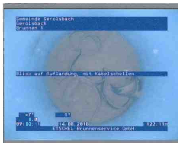
Foto: 1_1_29_14082018_090032_A.JPG 122,11m, Blick auf Auflandung / mit Kabelschellen
