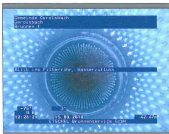
Foto: 1_1_15_15082018_122448_A.JPG 42,47m, Blick ins Filterrohr / Wasserzufluss
