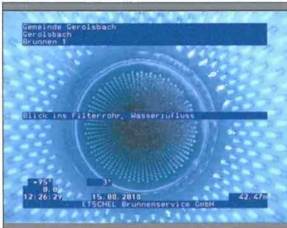
Foto: 1_1_15_15082018_122448_A.JPG 42,47m, Blick ins Filterrohr / Wasserzufluss
