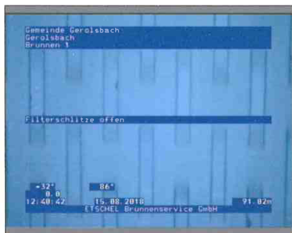
Foto: 1_1_24_15082018_123901_A.JPG 91,02m, Filterschlitze offen
