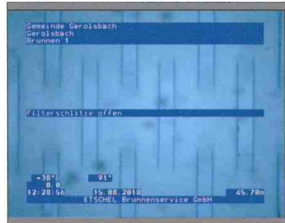
Foto: 1_1_17_15082018_122715_A.JPG 45,7m, Filterschlitz offen
