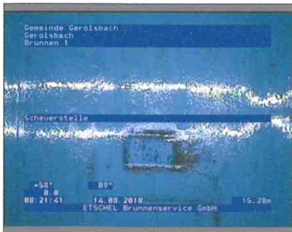
Foto: 1_1_7_14082018_082002_A.JPG 15,28m, Scheuerstelle
