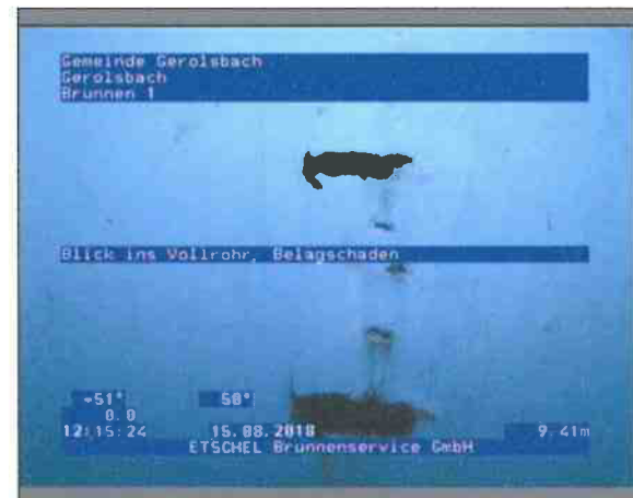
Foto: 1_1_6_15082018_121342_A.JPG 9,41m, Blick ins Vollrohr / Belagschaden
