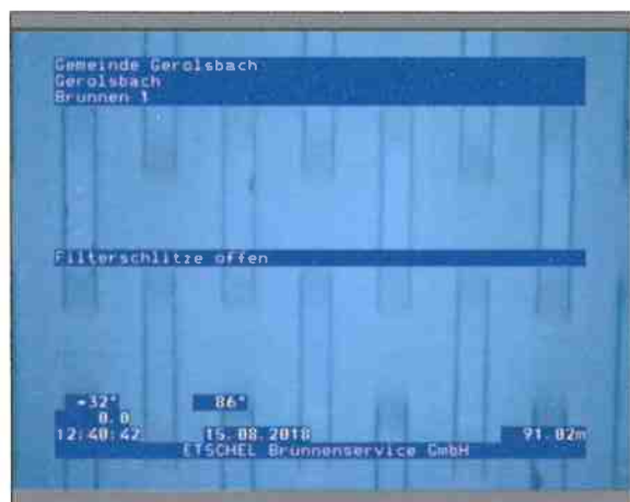
Foto: 1_1_24_15082018_123901_A.JPG 91,02m, Filterschlitzte offen
