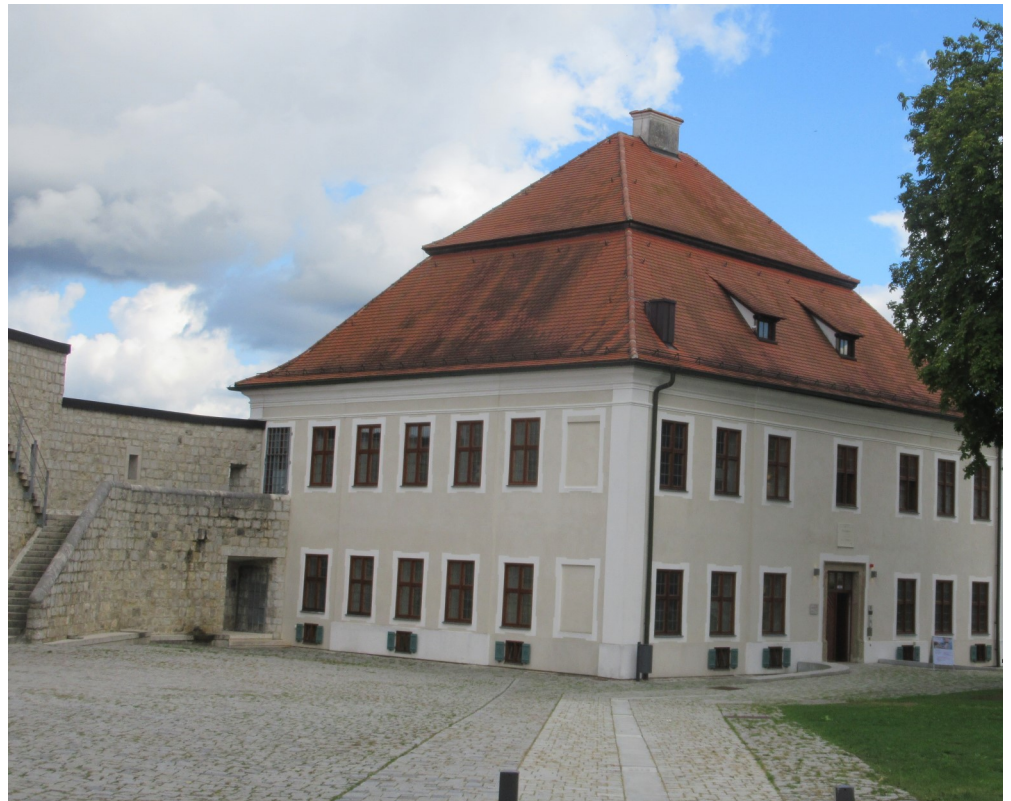
Das ehemalige Pflegerschloss in Vohburg mit einem im ersten Stock integrierten Museum (Burghof 4) feierte am Tag des offenen Denkmals seine Eröffnung.
