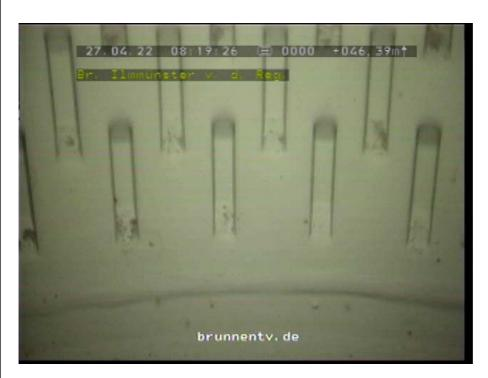
Foto : 17 Teufe : 46,39 m Video : 00:00:00 Kürzel : Ende Filterrohr
