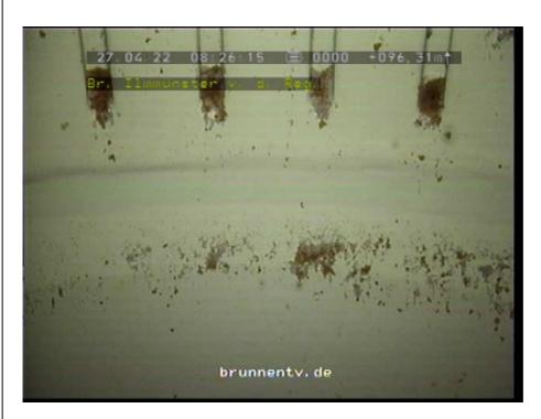
Foto : 25 Teufe : 96,31 m Video : 00:00:00 Kürzel : Ende Filterrohr
