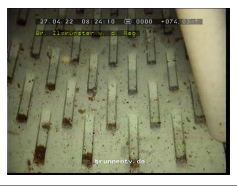
Foto : 22 Teufe : 74,03 m : 00:00:00 Video Kürzel : Ende Filterrohr
