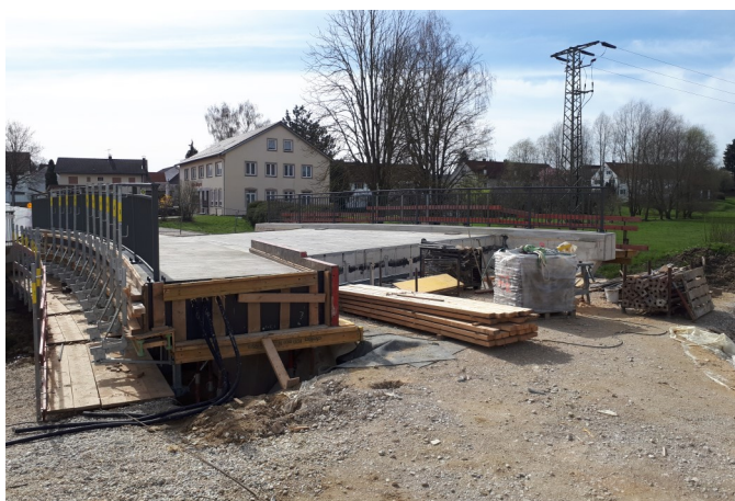
Es musste auch eine neue Brücke über den Gerolsbach errichtet und der Kanal verlegt werden.
