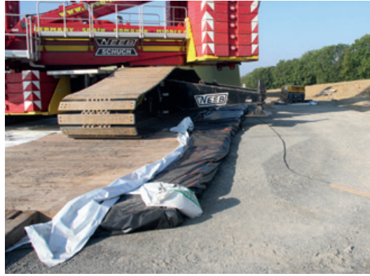
Abbildung 7: Ausgelegte Folie zum Gewässerschutz auf Baustellen (Quelle: Grünz & Brehm (2018)).
