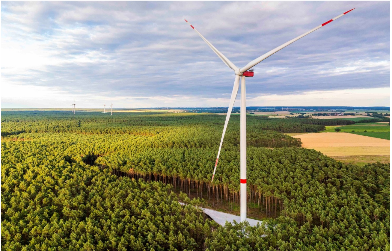
Abbildung 23: Anlage im Windpark Illmersdorf, Teltow-Fläming (Brandenburg)
