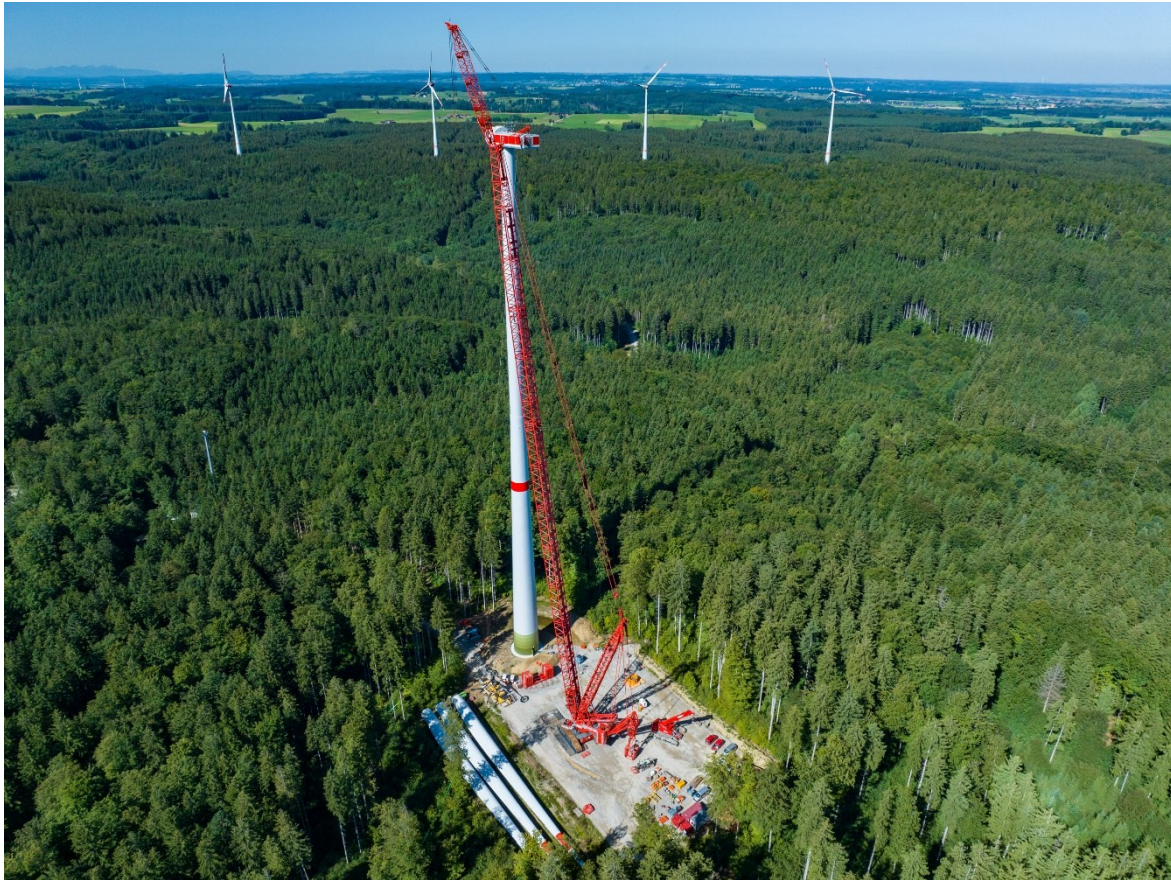
Abbildung 19: Anlagenerrichtung im Bürgerwindpark Fuchstal, Landkreis Landsberg am Lech (Bayern) Quelle: © Ingenieurbüro Sing (2024)
