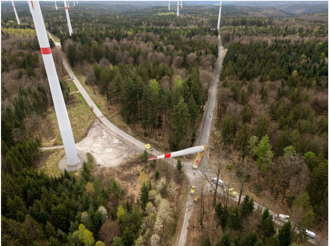
Abbildung 16: Rotorblattanlieferung im Windpark Sulzbach-Laufen, Schwäbisch Hall (Baden-Württemberg)
