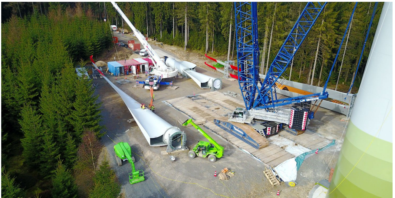
Abbildung 7: Kranstellfläche und temporäre Montageflächen während des Aufbaus einer Windenergieanlage Quelle: © Mark-E/Carsten Engel (2017)
