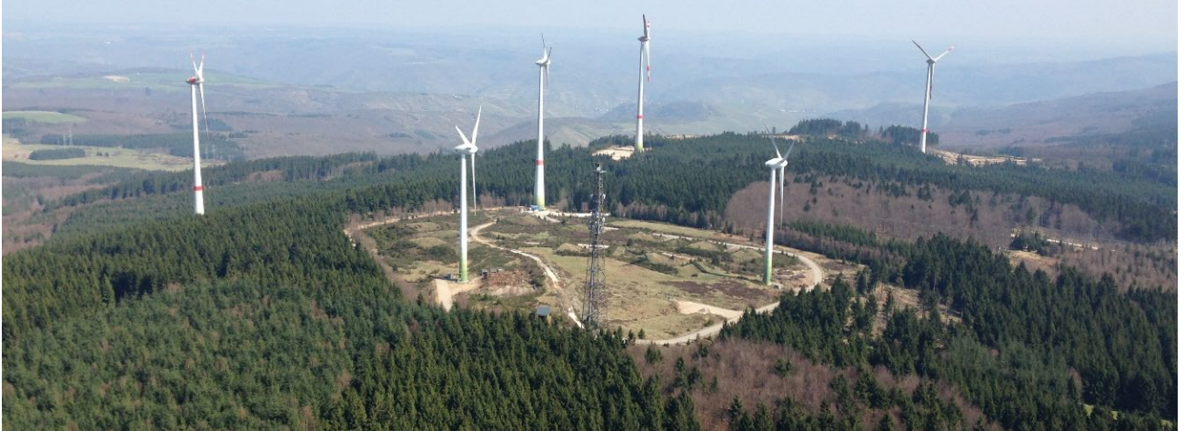
Abbildung 34: Windpark Kandrich auf ehemals militärisch genutztem Standort im Landkreis Bad Kreuznach (Rheinland-Pfalz) Quelle: © GEDEA-Ingelheim (2014)
