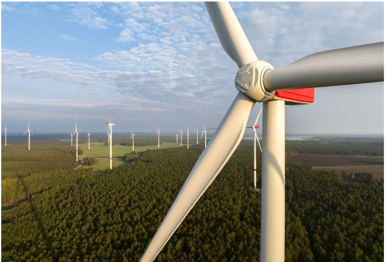
Abbildung 1: Windenergieanlagen im Kiefernforst
