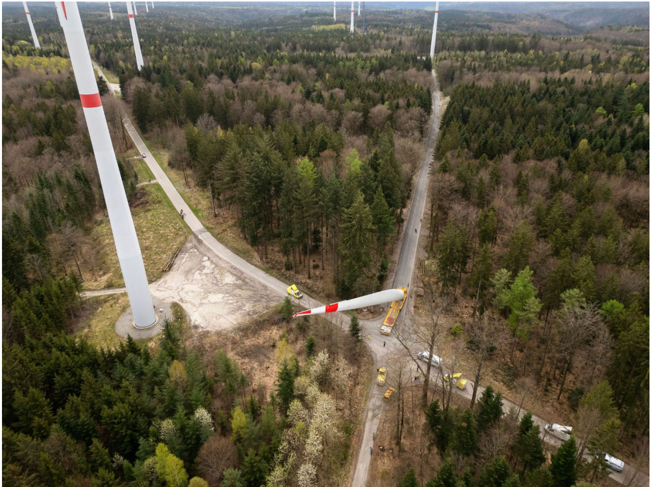
Abbildung 16: Rotorblattanlieferung im Windpark Sulzbach-Laufen, Schwäbisch Hall (Baden-Württemberg)
