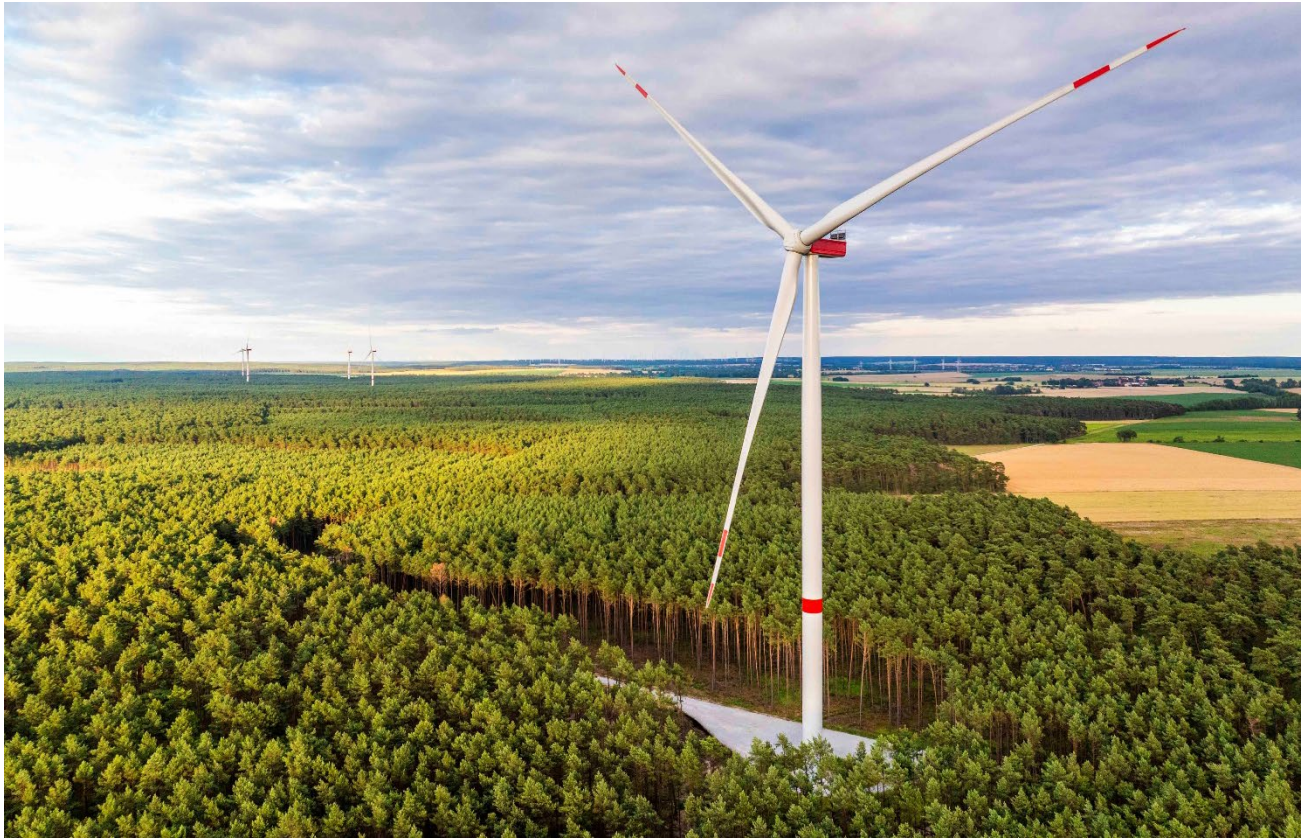
Abbildung 23: Anlage im Windpark Illmersdorf, Teltow-Fläming (Brandenburg)
