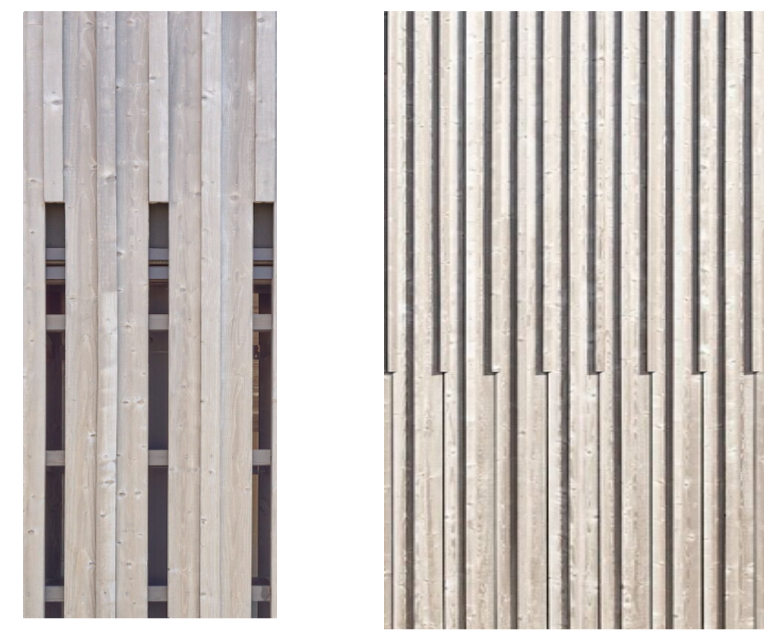
Fassade Giebel / Sockel Bodendeckel-Schalung z.B. Weißtanne
