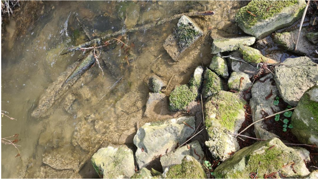
Abbildung 8-1: Gewässersohle Geisenhausener Bach
