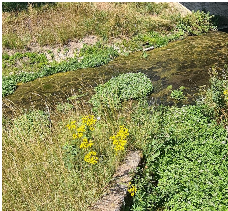
Abbildung 8-2: Gewässerbett an der Einleitstelle des RUE 398
