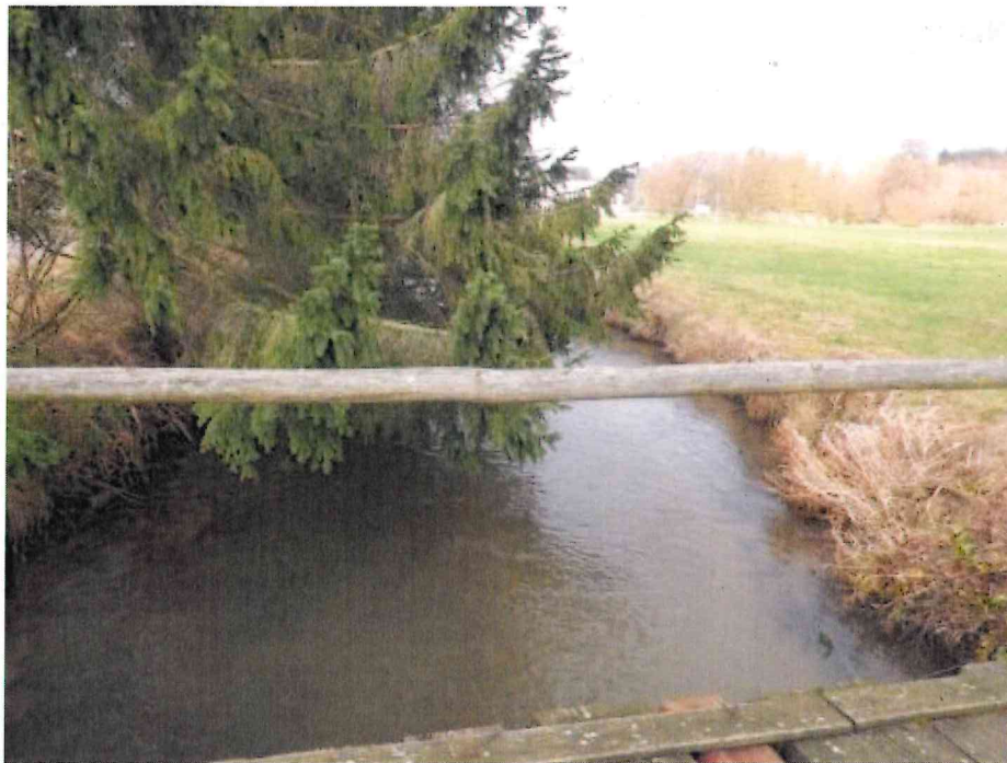
Lage der Messstelle Holzbrücke Ilmweg Hettenshausen, FKm56,6 / Ilm
