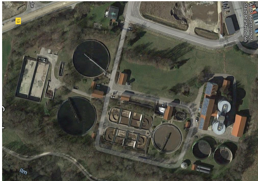
Abbildung 1: Luftbild der Kläranlage Pfaffenhofen (Quelle: google.com/maps)
