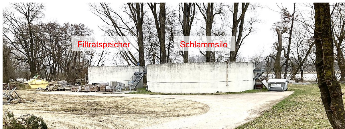
Abbildung 3-11: Filtratspeicher und Schlammsilo (BBI INGENIEURE GMBH, Aufnahme vom 29.02.2024)
