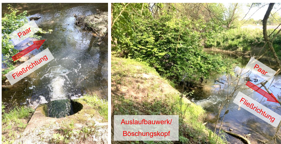
Abbildung 3-5: Bestehende Einleitstelle in die Paar (BBI INGENIEURE GMBH, Aufnahme vom 30.04.2025)
