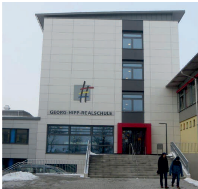
Die Sanierung der Realschule Pfaffenhofen läuft auf Hochtouren.
