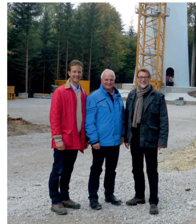
Landrat Martin Wolf (r.) mit Bürgermeister Martin Seitz (Mitte) und Dr. Stefan Detig (l.) am Tag der offenen Baustelle in Gerolsbach. (Foto: Bürger-Energie-Genossenschaft im Landkreis Pfaffenhofen a.d.Ilm e.G.)
