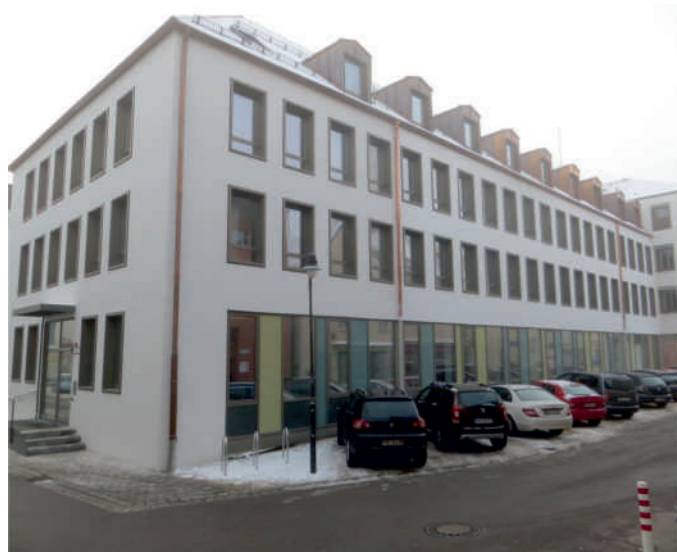
Der zweite Bauabschnitt des generalsanierten Landratsamts ist bezugsfertig.
