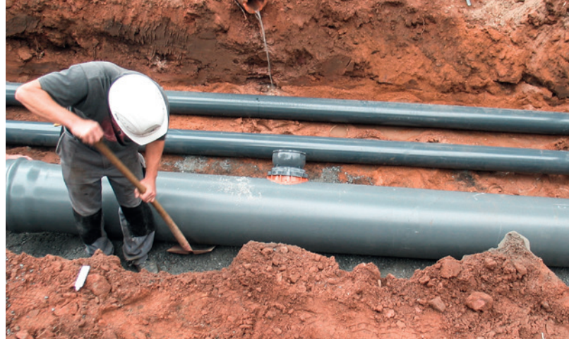
Für Sanierungen in offener Bauweise, wird der Boden aufgedigelt.
